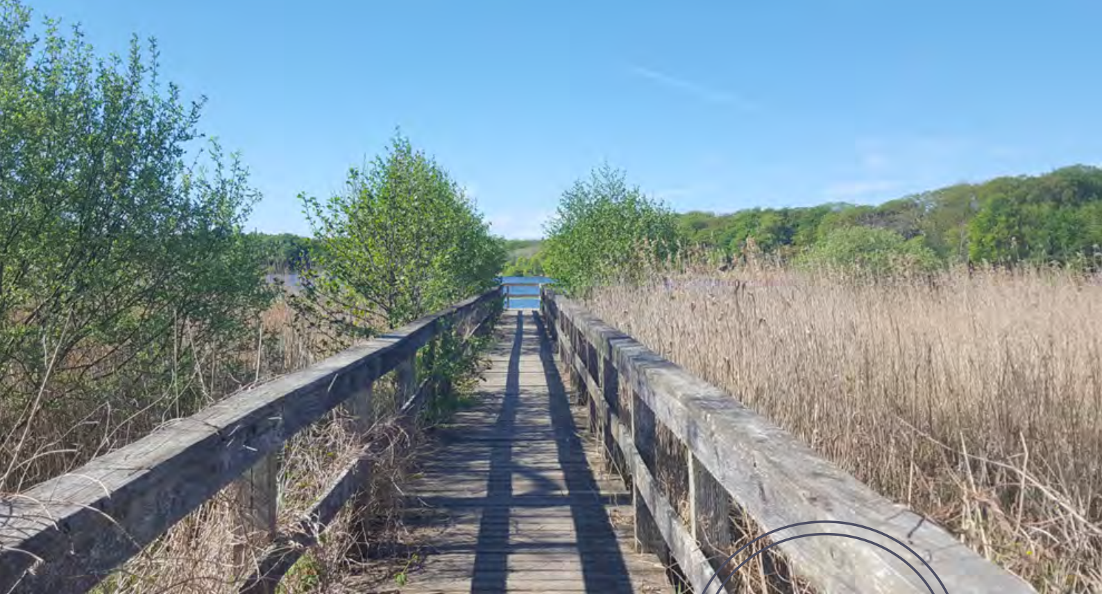
DEN EKSISTERENDE BRO VED CAMPINGPLADSEN
