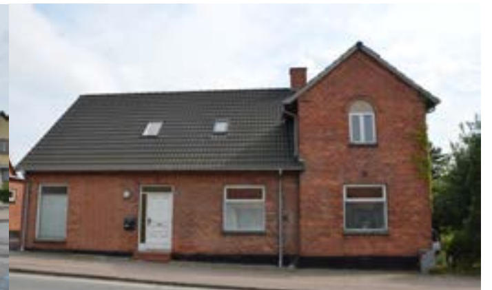
② Typisk rødstensbygning oprindeligt med blandet bolig og erhverv, Hovedgaden 7. Det er bygninger som denne der giver Ugerløse karakter af stationsby
