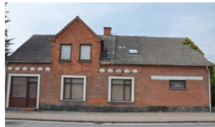
⑤ Den tidligere slagter er en af de typiske rødstensbygninger med blandet bolig og erhverv, Hovedgaden 28.
